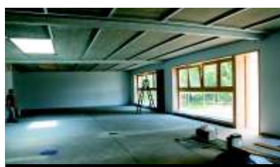
W tej sali zamontowane zostaną ściany rozsuwane
